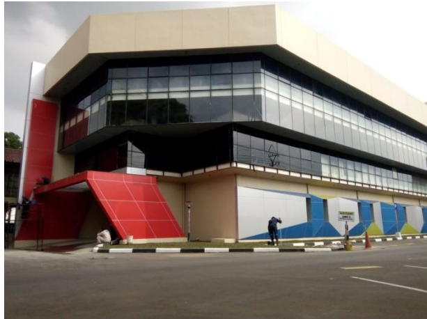
Progres pengerjaan façade-pintu utama Ruang Demo Room RU- IV Pertamina Cilacap
