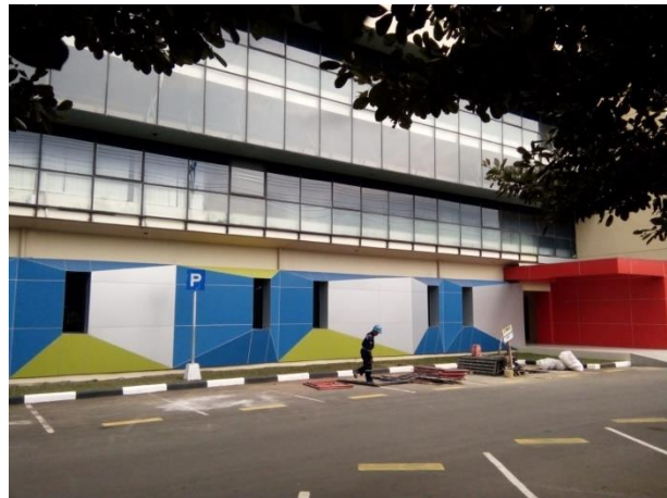
Progres pengerjaan façade arah parkir gedung Demo Room RU- IV Pertamina Cilacap
